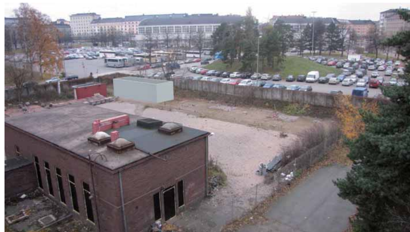
Kuva 6.79. Stadionin etukentän pystykuilu.
