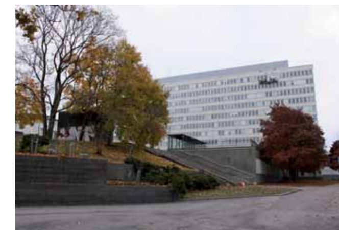
Kuva 6.101. Hakaniemen ajotunnelin virastotalon portaiden kohdalla. Alue palautetaan Pisaran valmistuttua.
